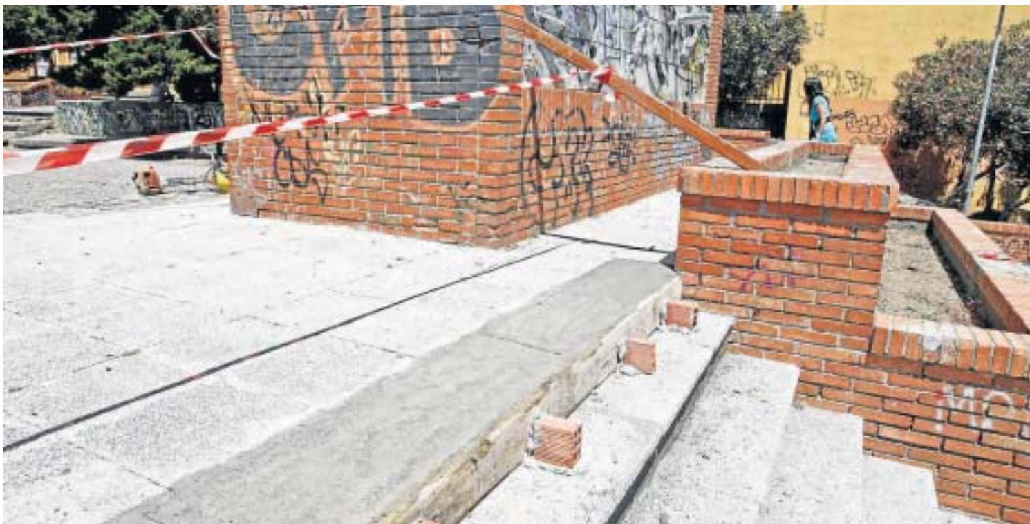
Imagen de los trabajos que se vienen realizando para acondicionar la escalinata de La Reconquista, ayer.
